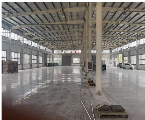
生产车间内部
