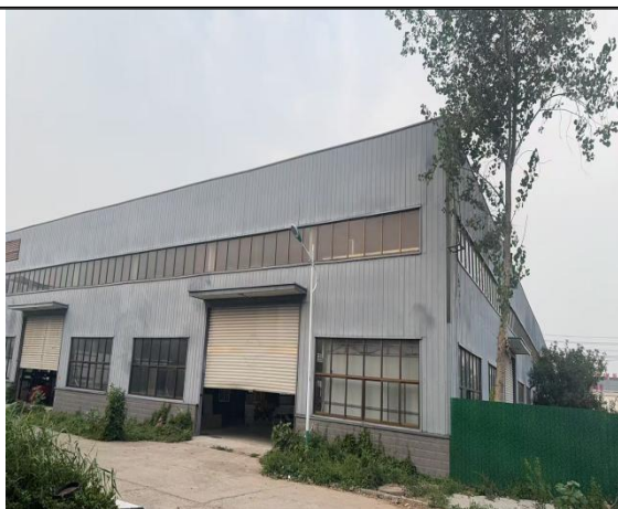
生产车间外部
