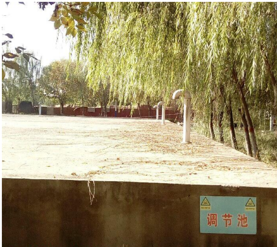
图 2-1-5 渗滤液调节池
