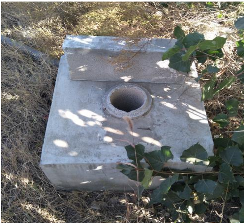
图 4-7 地下水监测井
