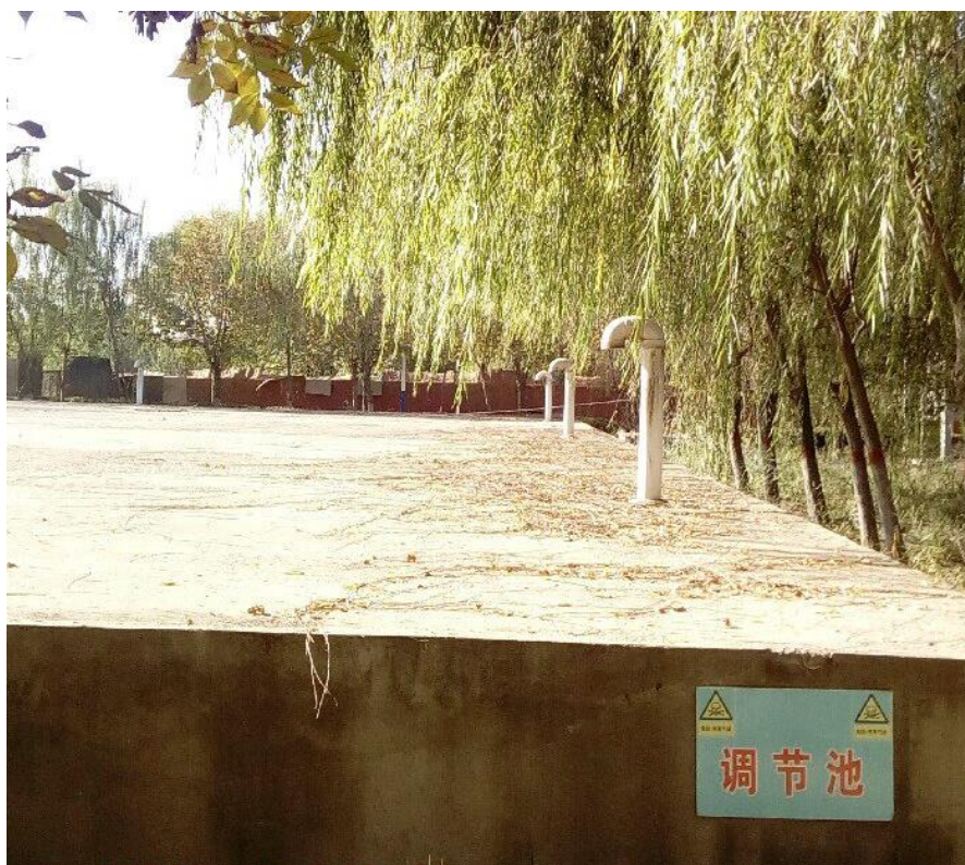
图 4-8 渗滤液调节池
